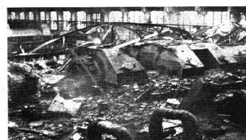
Рис. 2. Общий вид аварии ТА 300 МВт (2002 г.)
